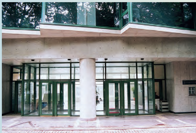
研究科棟正面玄関
