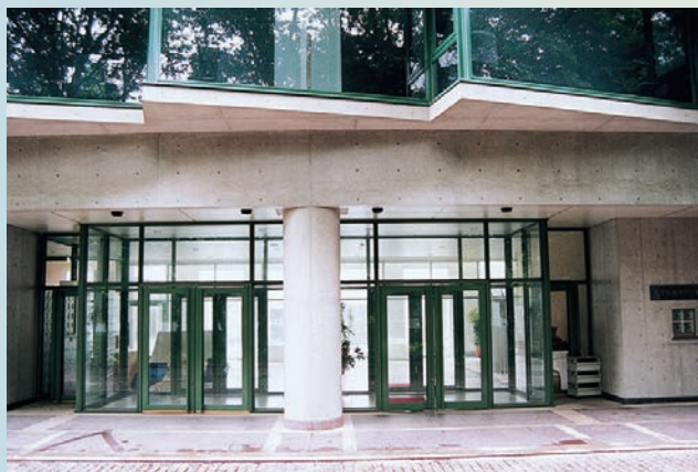
研究科棟正面玄関
