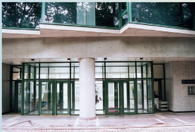
研究科棟正面玄関
