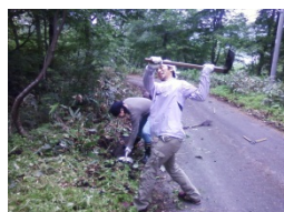
側溝の泥の除去作業
