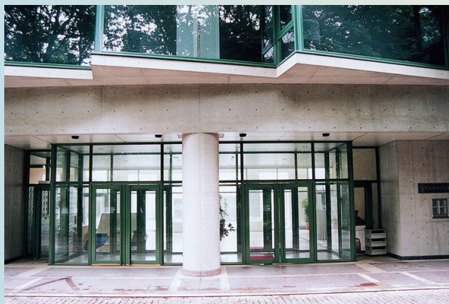
研究科棟正面玄関
